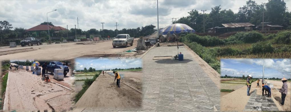
งานตรวจสอบงานปูแผ่นกระเบื้อง ขนาด (๐.๔๐x๐.๔๐x๐.๐๓๕) เมตร บริเวณทางเท้า กม.ที่ ๑๒+๖๐๐ - ๑๒+๖๕๐ LT, RT ตอนที ๑
