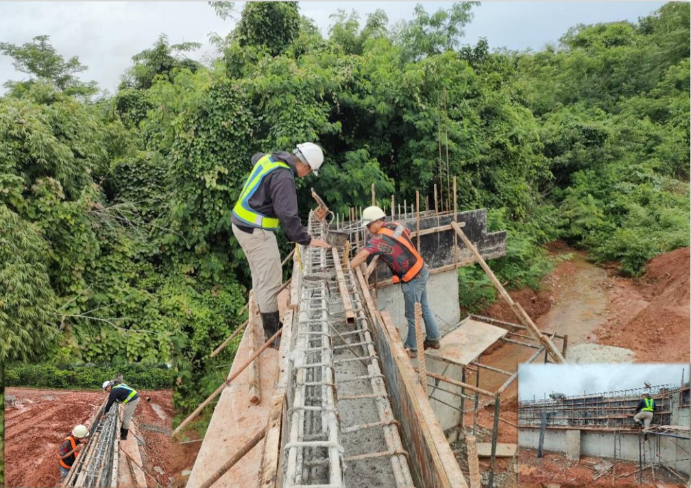
งานตรวจสอบเหล็กเสริมคานขวางรัดหัวเสา Step ๒ ตับ P๑ (RT ) สะพาน กม.ที่ ๑+ ๔๐๐ ตอนที ๑
